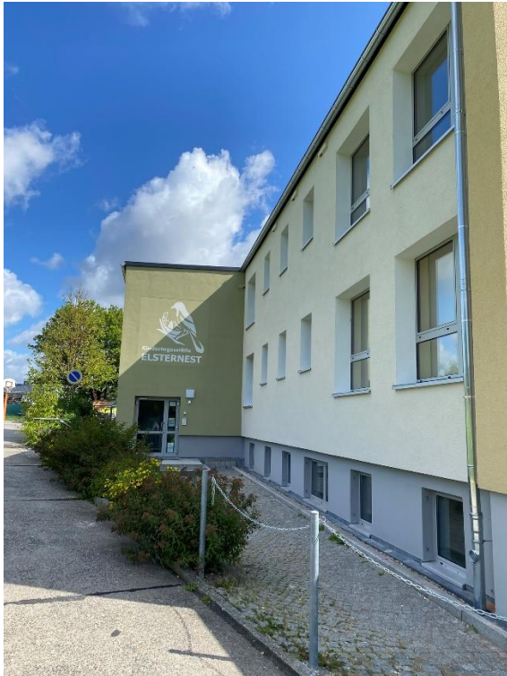
Ansicht Haupteingang Kita / Hort
