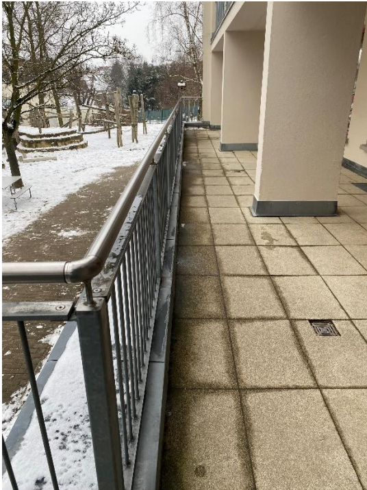
Sicht auf Terrasse Erdgeschoss (Anbau Rampe geplant)
