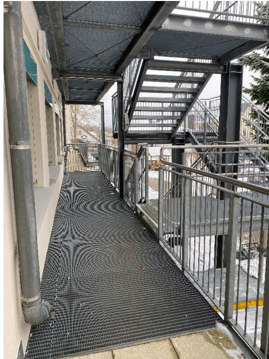
bestehende Außentreppe (nicht barrierefrei)
