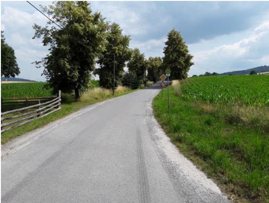
Zustand Haltestelle Abzweig Welka Richtung Boderitz/Elstra
