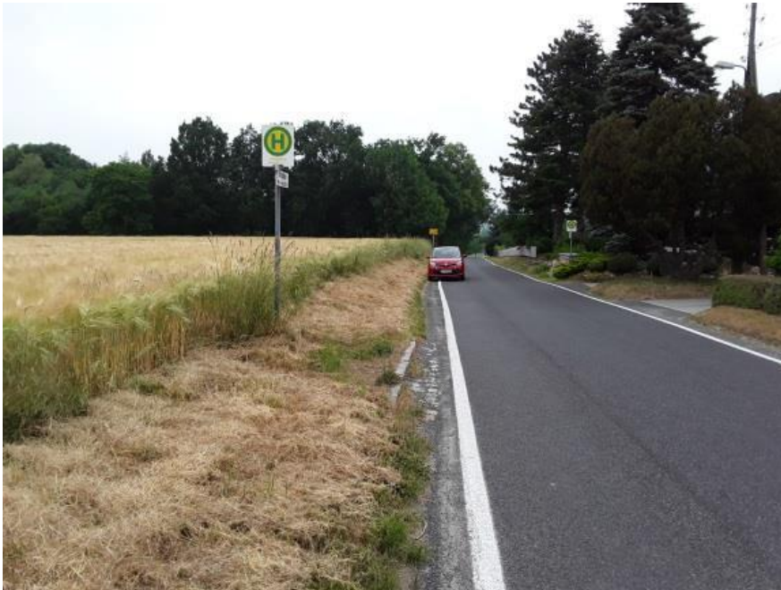
Zustand Haltestelle Prietitz Weinbergstraße Richtung Ortsmitte Prietitz
