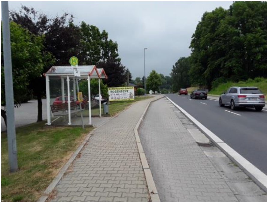
Zustand Haltestelle Prietitz Gasthaus Richtung Kamenz
