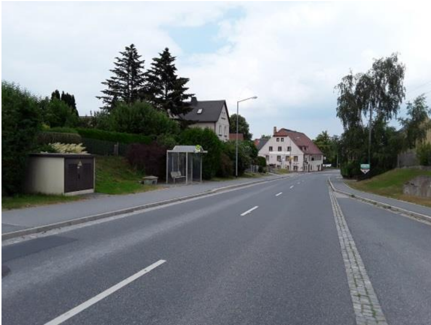
Zustand Haltestelle Rauschwitz Richtung Bischofswerda
