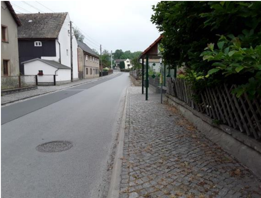
Zustand Haltestelle Prietitz Ort Richtung Elstra/Hennerdorf
