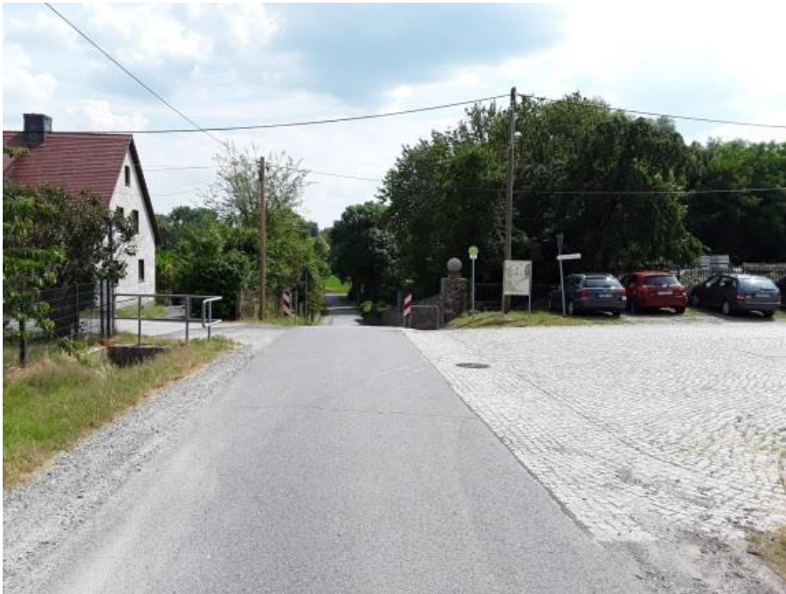
Zustand Haltestelle Wohla Richtung Boderitz/Elstra
