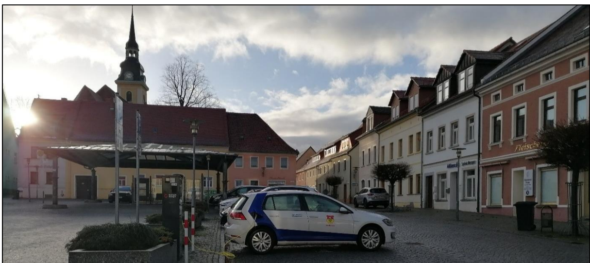
Abb. 7: Ladestation für Elektroautos auf dem Marktplatz Elstra, Foto (LA Panse, 02.02.23)
